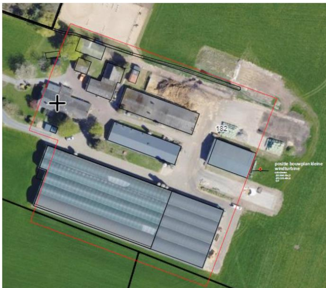
Figuur 3: Luchtfoto positie bouwplan kleine windturbine (bron: aanvraag omgevingsvergunning)
