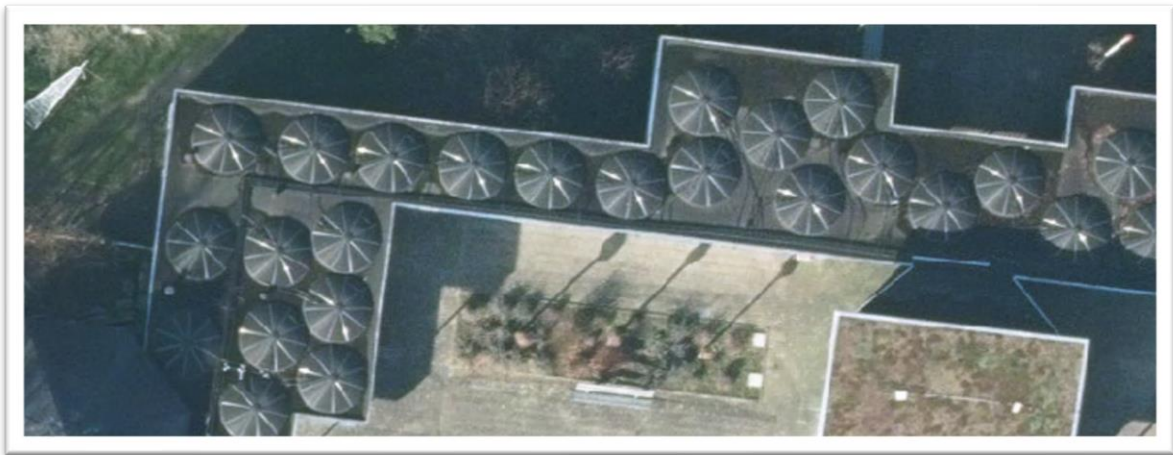
Figuur 7. Het dak van het zwembad is ongeschikt voor het plaatsen van zonnepanelen.
