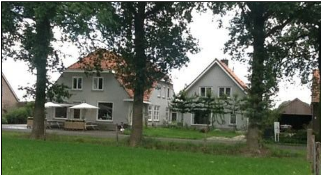
Bestaande situatie perceel Holterweg 110 met rechts de woning en links het voormalige bedrijfspand/ winkel nadat dit pand werd verbouwd tot woonruimte (bron: Google Streetview)
