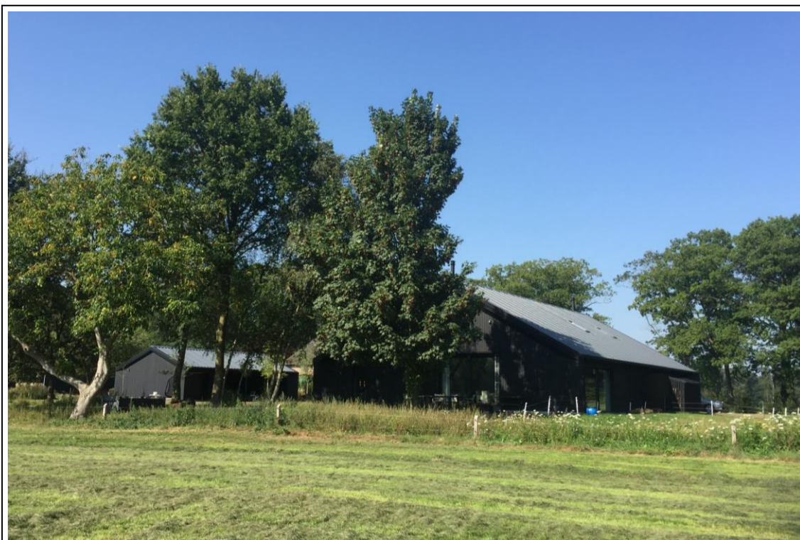
Figuur 7 - Holmershuizen 7, werkgebouw(rechts) en voertuigloods (links gezien vanaf het weiland (Bron: Landgoed Kranengoor, vanuit oosten)
