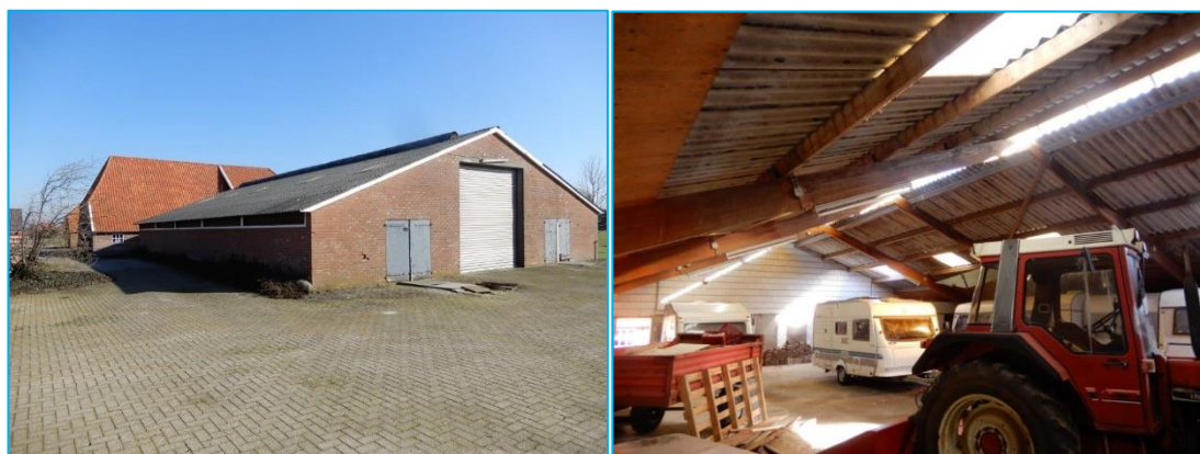
Foto's: Indrukken plangebied. De te amoveren opstallen.
