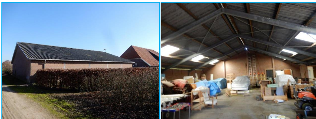
Foto's: Indrukken plangebied. De te amoveren opstallen.
