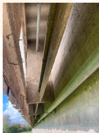
2i. Ventilatiekanaal met fijn gaas
