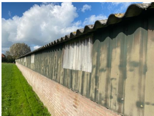
2c. Zuidelijke gevel
