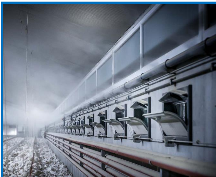
Figuur 7 Voorbeeld nevelkoeling
