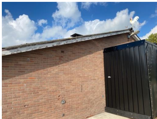
2b. Aansluiting windveer en boeidelen
