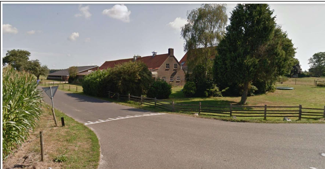
Figuur 8 - Harfsense Steeg 19 in richting Deventerdijk gezien met de oude (te slopen) schuur op de voorgrond (Bron: Google Streetview)
