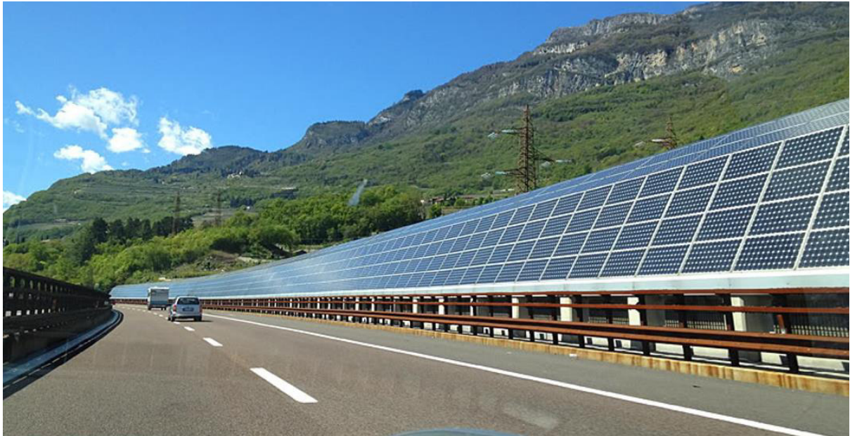
Figuur 3: Zonne installatie langs de “Brennerautobahn” in Italië
