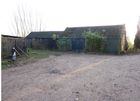
Foto's: te slopen gebouwen
