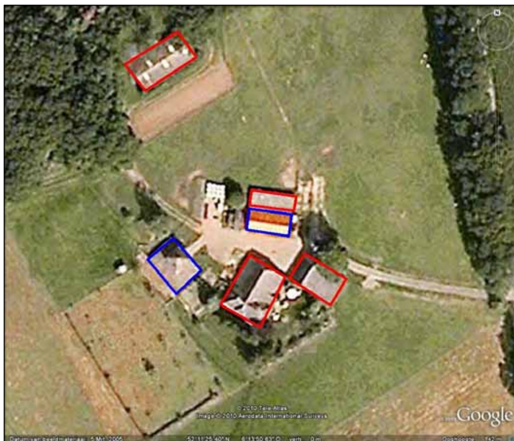
Luchtfoto plangebied met de te slopen (rood) en behouden (blauw) bebouwing (bron luchtfoto: Google Earth)
