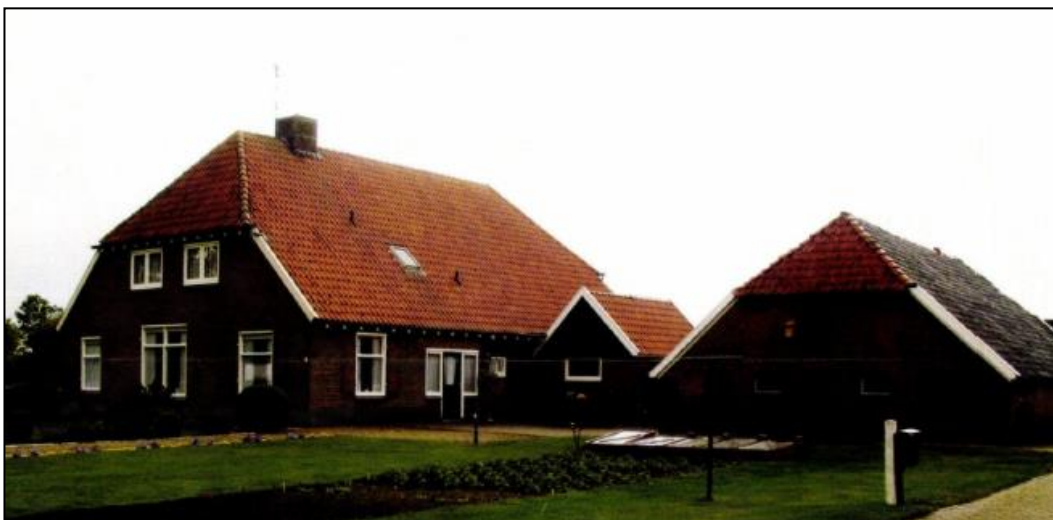
Woning Groenedijk 7 met naastgelegen schuur, georiënteerd op de Groenedijk (bron: Buro Dwarsstraat/Bongers Landschap)
