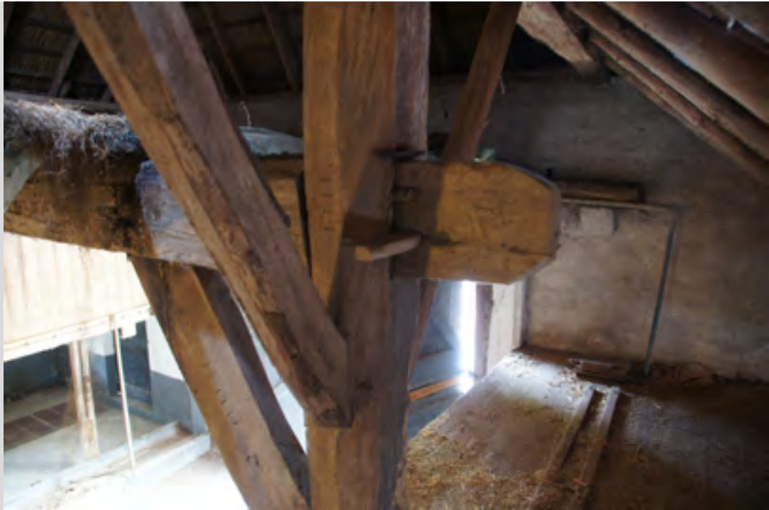
Close-up constructie boerderij
