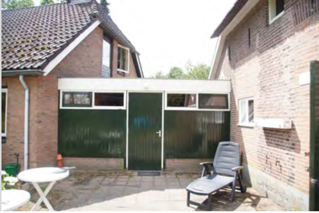
Verbinding woonhuis en boerderij (west)
