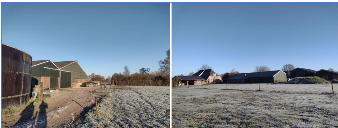
Figuur 15. Foto's van het plangebied met links de koeienstal en silo; op de rechterfoto de oostzijde van de te slopen opslag (met zandbult) en daarachter wederom de koeienstal (gemaakt op 14 december 2022).
