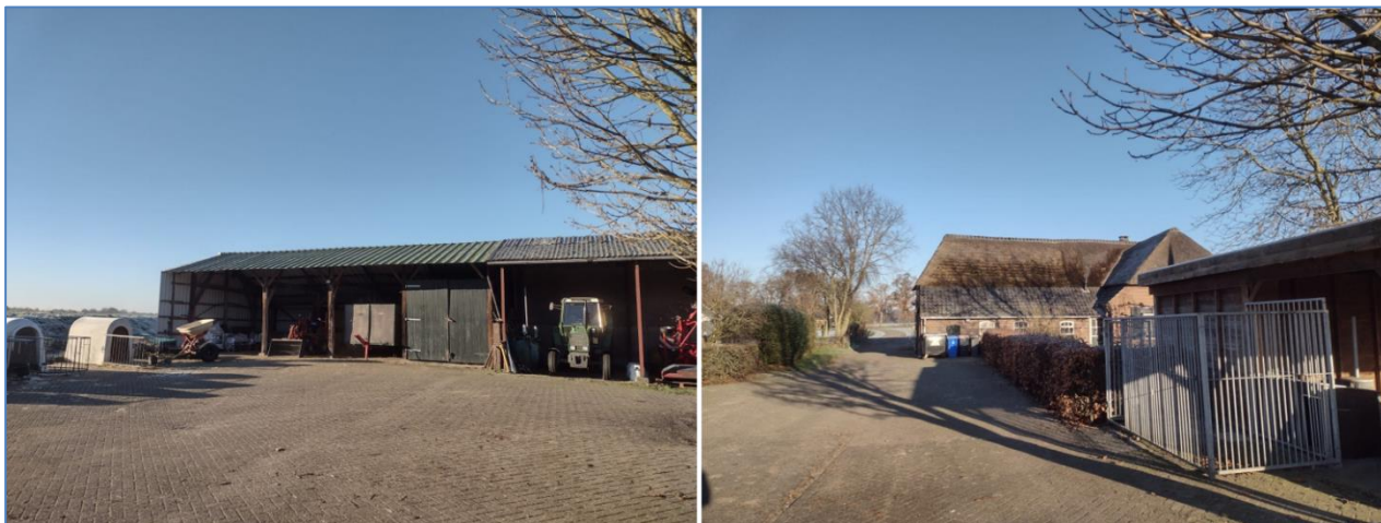
Figuur 14. Foto's van het plangebied met links de te slopen opslag en stalling; rechts het bestaande woonhuis met op de voorgrond het te slopen bijgebouwtje (gemaakt op 14 december 2022).
