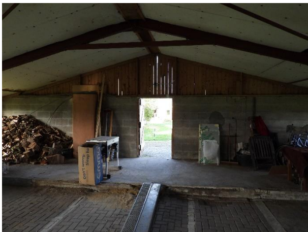
Steens muren en gevelbetimmering zonder holle ruimte, maken de gevel tot een ongeschikte verblijfplaats voor vleermuizen en andere dieren.
