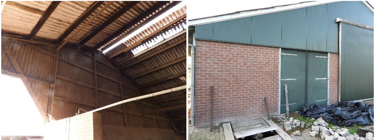
Gevelbekleding van damwand (links) en gemetselde buitengevels zonder openingen vormen geen potentiële verblijfplaats voor vleermuizen.
