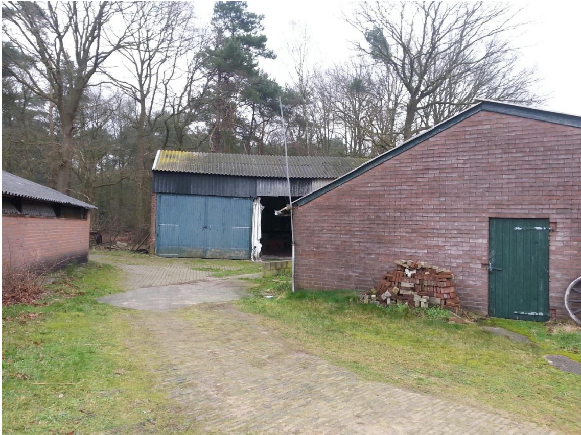
Het plangebied, rechts één van de schuren die afgebroken gaat worden
