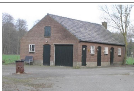
Figuur 10 – Te behouden bijgebouw (vanuit zuidwesten)
