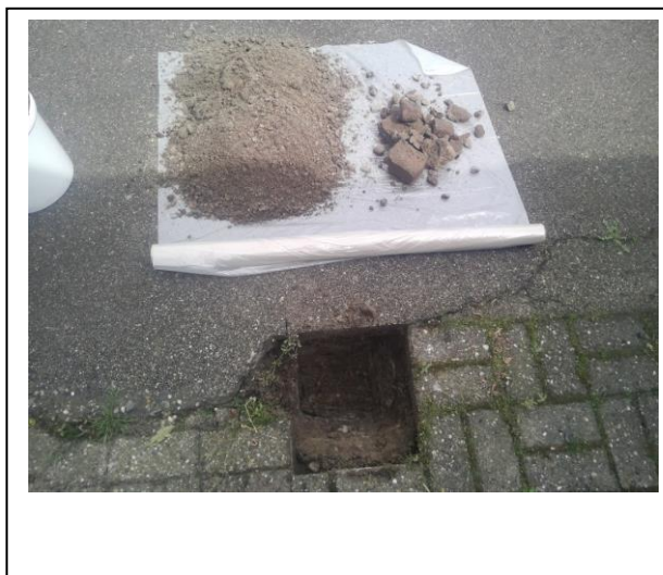
Foto: Inspectiegat D104 (0,1-0,5 m -mv)
