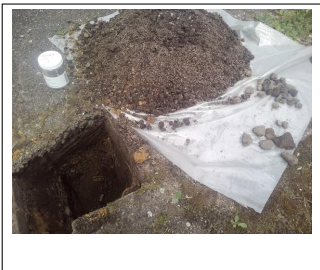
Foto: Inspectiegat D103 (0,1-0,5 m -mv)
