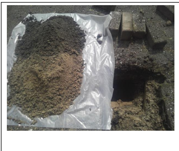
Foto: Inspectiegat D105 (0,1-0,5 m -mv)
