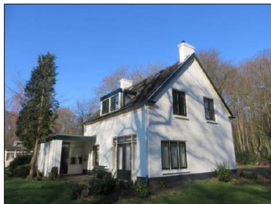
Figuur 8: De bestaande bedrijfswoning (Ehzerallee 11)
