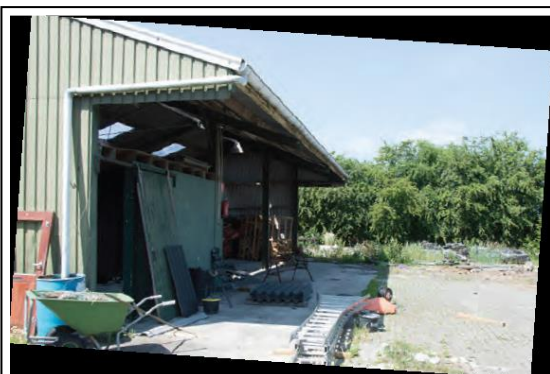
Figuur 5 – te slopen kapschuur (loods)
