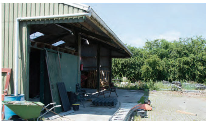
Afbeelding 2. Te slopen kapschuur
