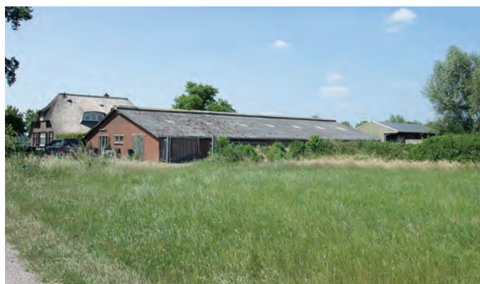
Afbeelding 3. Te slopen schuur
