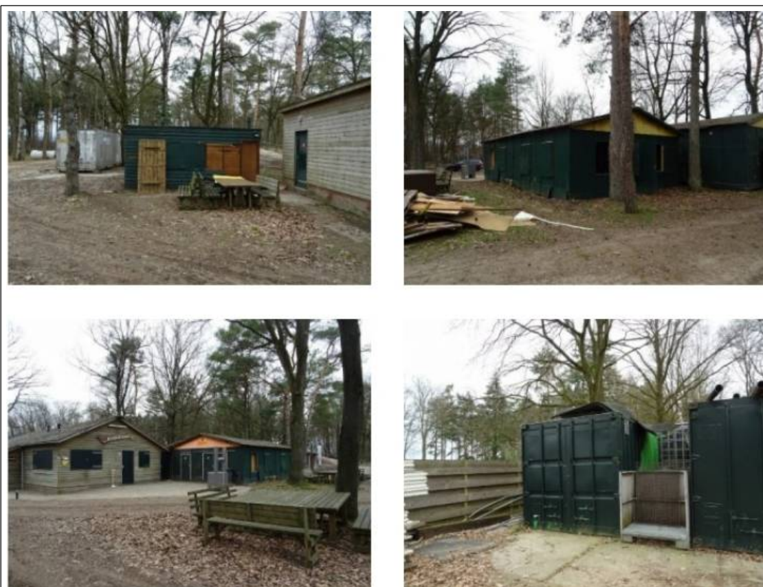
Figuur 5 – Bestaande gebouwen/opstallen op het motorcrossterrein (bron: Econsultancy)
