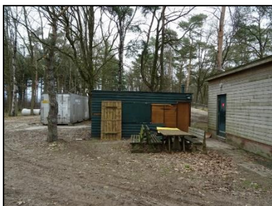
Figuur 6. Barak links (gebouw 6) en toiletgebouw (gebouw 2) rechts.
