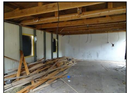
Figuur 5. Binnenzijde leegstaande barak.
