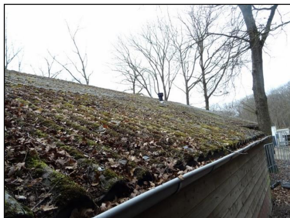
Figuur 11. De goten liggen vol met bladeren.
