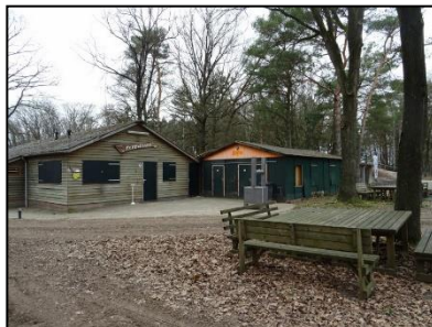
Figuur 4. Kantine links (gebouw 1) en één van de barakken (gebouw 4) rechts.
