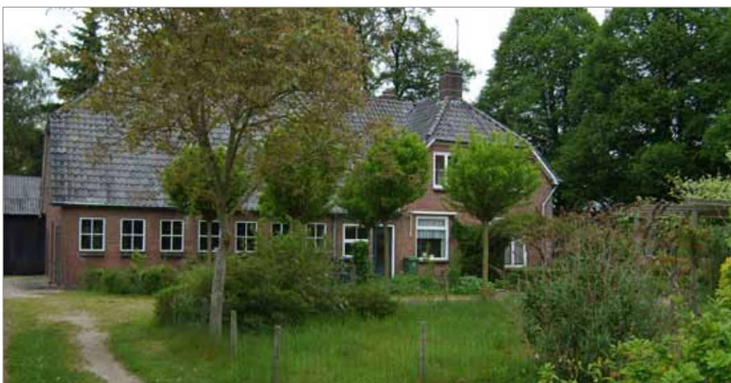
Afbeelding 6. Foto: te slopen boerderij en siertuin
