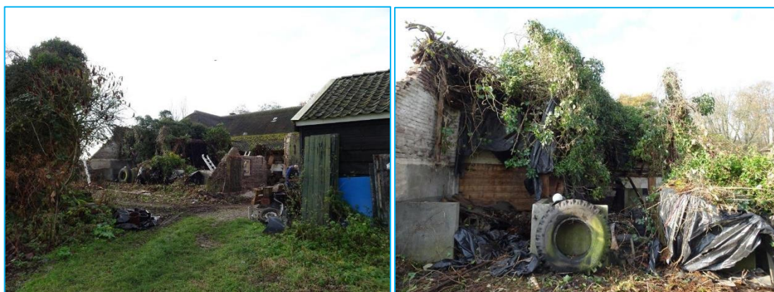
Foto's: Indrukken plangebied. Vervallen winkel/ aanbouw.
