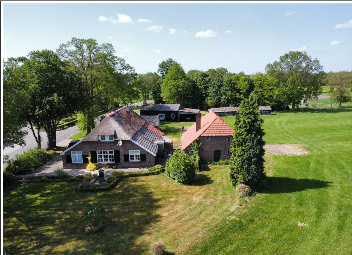
Figuur 7 - Overzicht bestaande inrichting erf (bron: Funda.nl)
