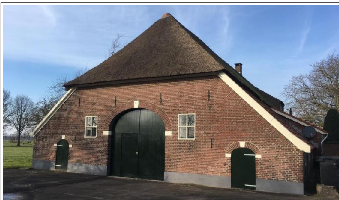
Figuur 5 – Achterzijde boerderij (deel)
