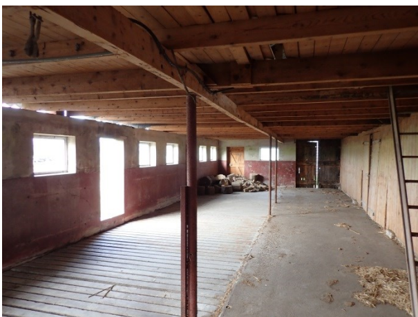
Foto 3: het stalgedeelte dat in de werktuigenberging (d) is gebouwd. De muur op de foto is de spouwmuur die aan de bovenzijde volledig open is.
