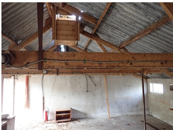
Foto 6: het interieur van de varkensstal (e) met de niet beschoten kap.
