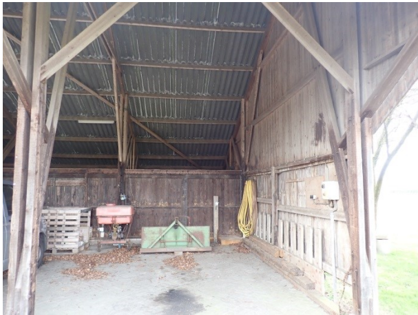
Foto 4: de werktuigenberging (d)aan de oostzijde. De enkelvoudige wanden en het niet beschoten dak zijn zichtbaar. De houtenwand achterin is de wand van de stal van foto 3.
