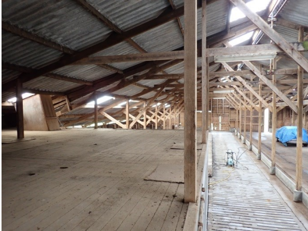
Foto 1: de voormalige loopstal (c) gezien vanaf het plankenplafond van de melkstal die in deze loopstal is gebouwd.
