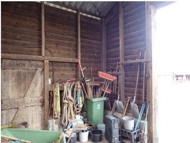
Foto 2: de wand van de loopstal (c) op een lage borstwering. Ook het niet beschoten dak is zichtbaar.
