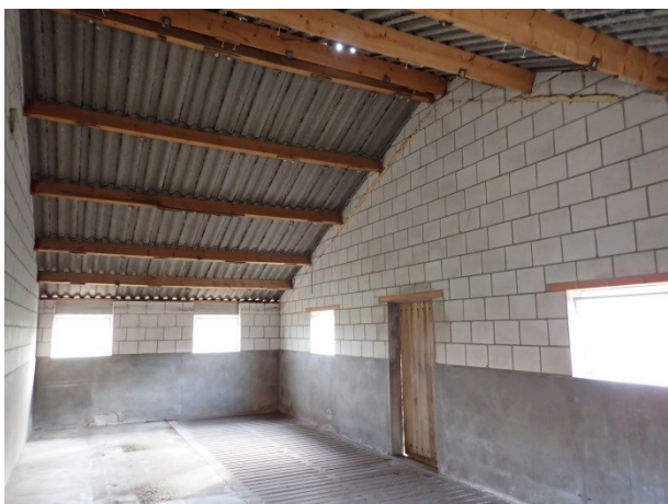
Foto 8: het interieur van de grote varkensstal (f) met de niet beschoten kap van cementgebonden platen.
