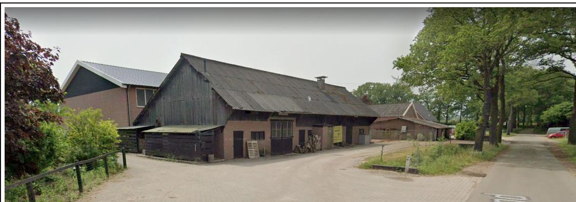
Figuur 7 – Blauwhand 1 met wegbrug vanaf de weg (bron: Google Street view)
