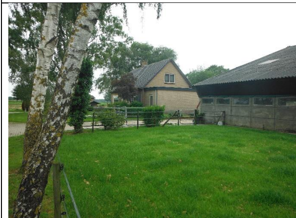
Vanuit noordoostelijke richting nabij boring 11
