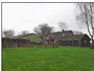
Figuur 6. De schuur (7) zuidelijk op de onderzoekslocatie, met daarachter het woonhuis (6).
