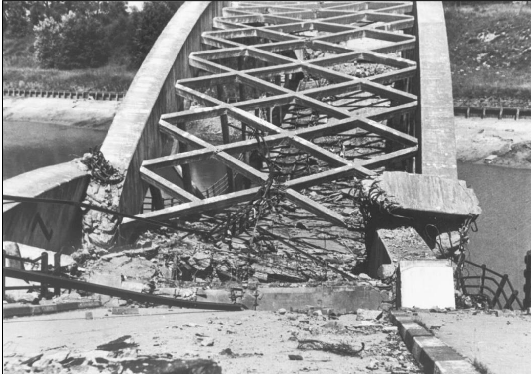
Afbeelding 10: Vernielde brug over het Twentekanaal in Lochem. Bron: beeldbankwo2.nl, beeldnummer: 73853.
