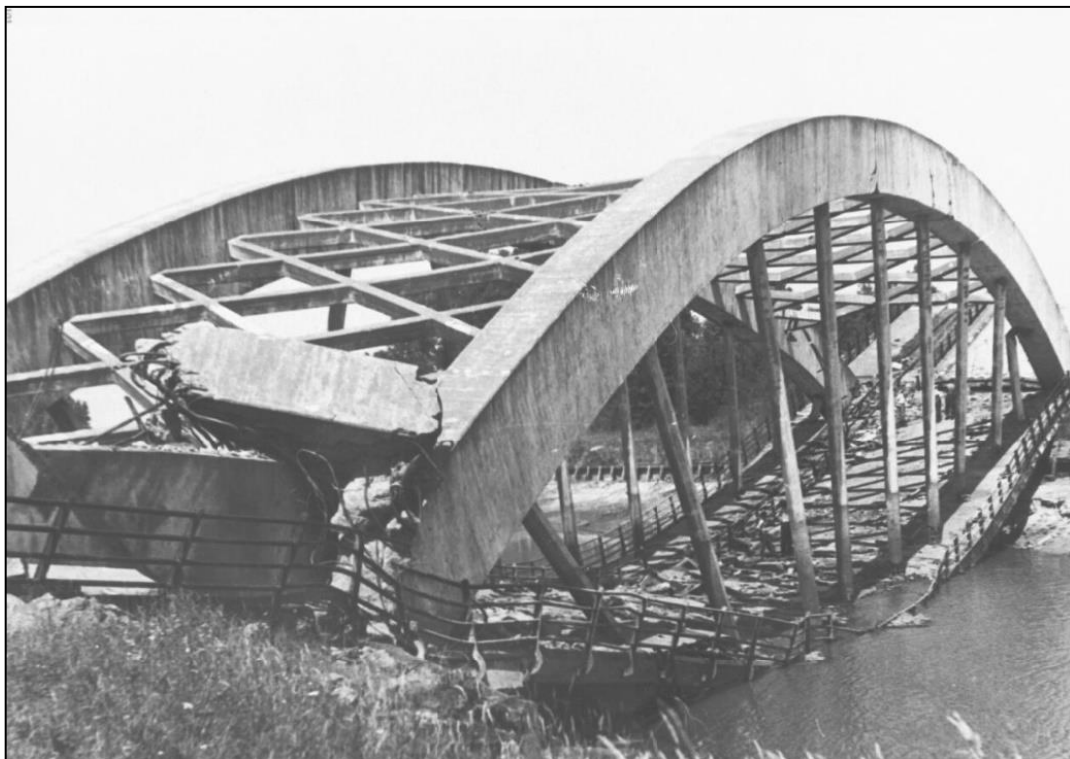
Afbeelding 9: Vernielde brug over het Twentekanaal in Lochem. Bron: beeldbankwo2.nl, beeldnummer: 73852.
