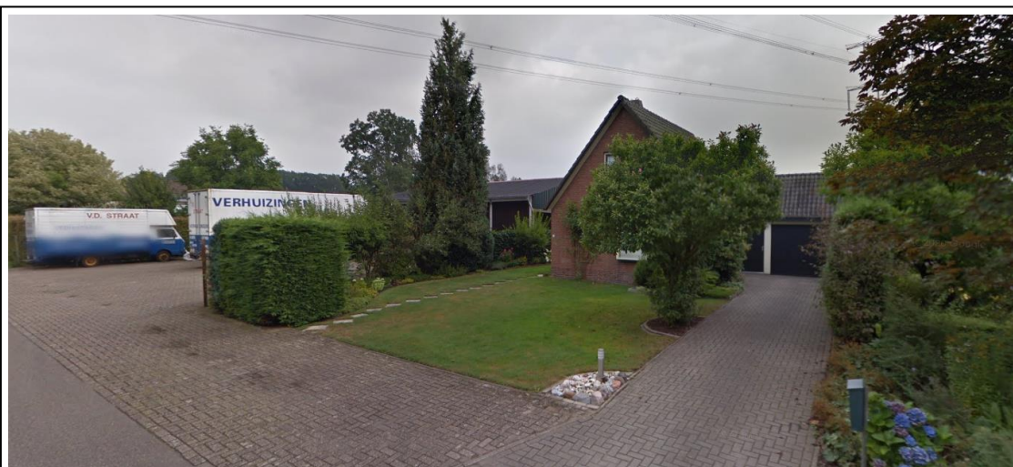
Figuur 6 – Situatie plangebied (voor de brand), gezien vanaf de Dorpsstraat vanuit het zuiden (bron: Google Streetview)
