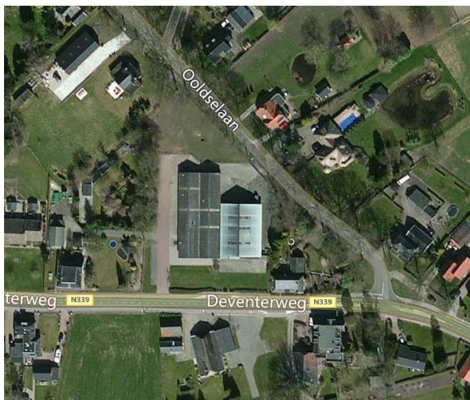
Afbeelding: luchtfoto huidige situatie
