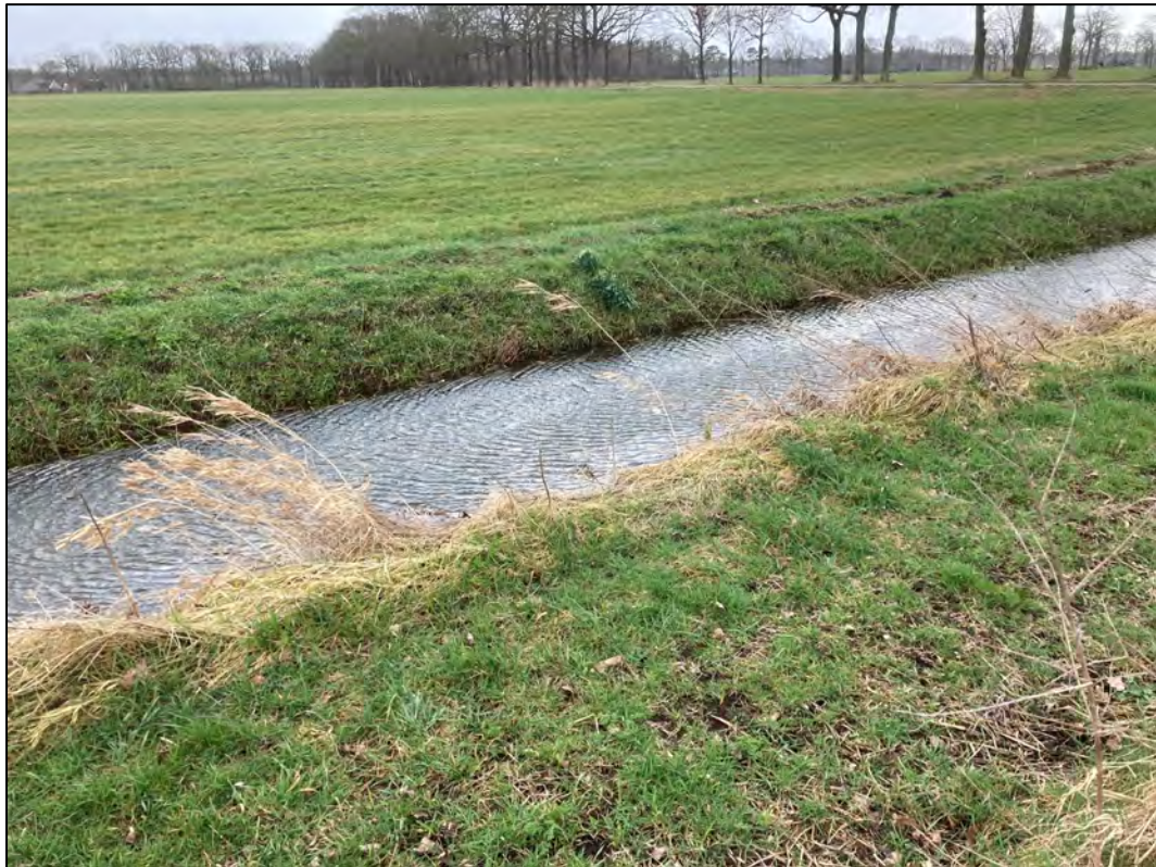
Zicht op beek De Visserij vanuit het plangebied. Op de achtergrond is de weg Witzand met begeleidende beplanting zichtbaar.
