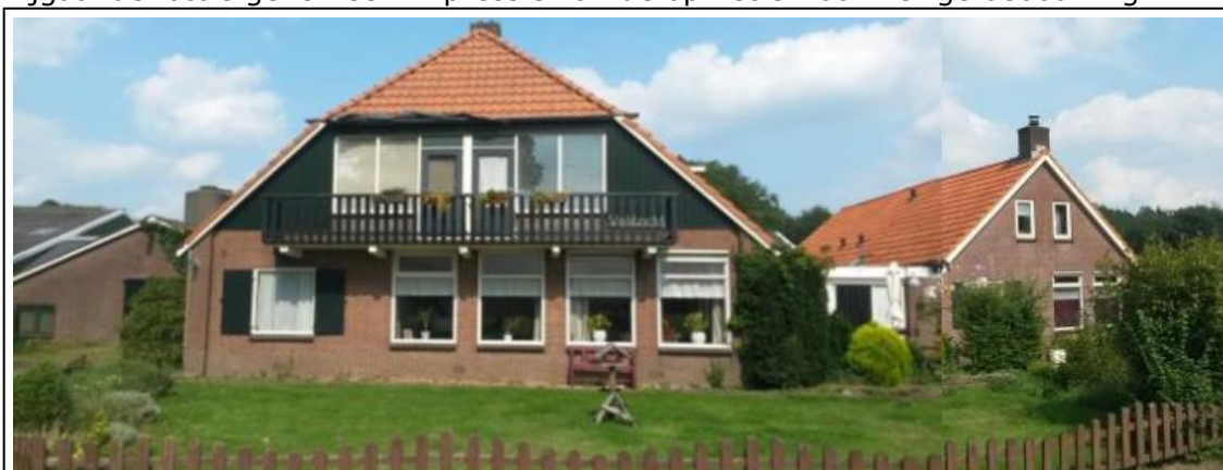
Figuur 5 - huidige bedrijfswoningen (rechts de 2 e bedrijfswoning)
