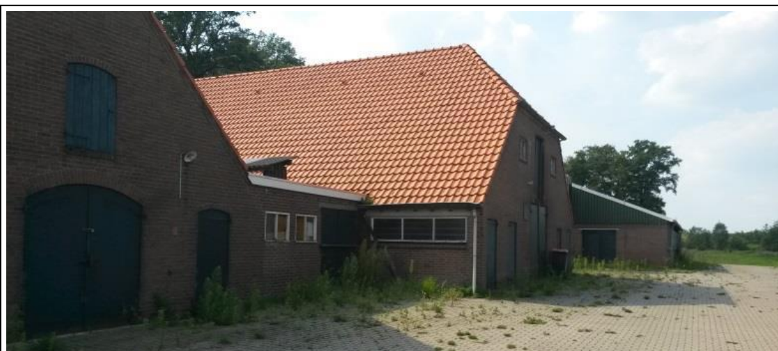
Figuur 6 – Achterzijde bedrijfswoningen (originele deel en schuur)
