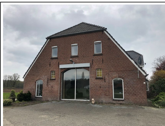
Figuur 9 –achterzijde (deel) bestaande boerderij
