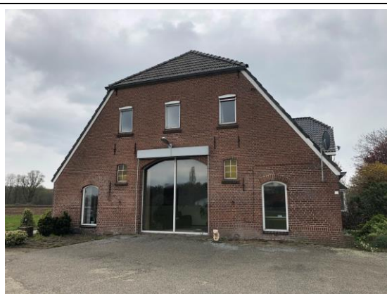
Figuur 9 –achterzijde (deel) bestaande boerderij
