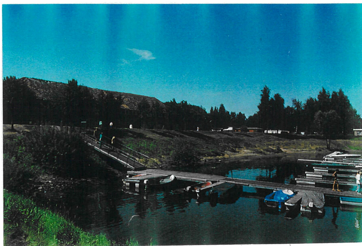
Gebouwencomplex aan de rivier, met nooddijk en jachthaven
