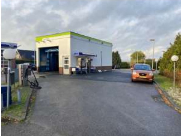
Figuur 12: Overzichtsfoto onderzoekslocatie
