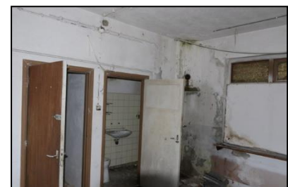
Figuur 11. Binnenzijde schuur.
