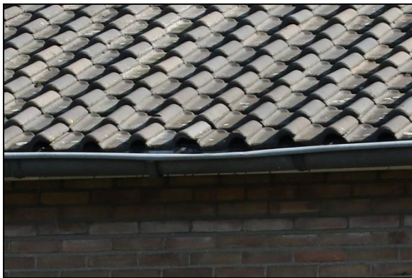
Figuur 13. Dakrand woonhuis met ruimte onder dakpannen.
