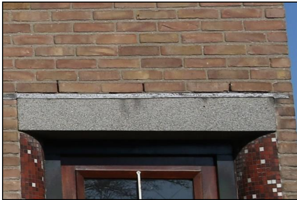
Figuur 16. Stootvoegen boven deurpost.
