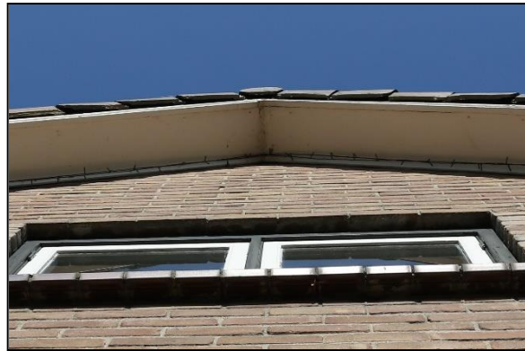
Figuur 17. Dakranden met openingen.
