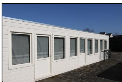
Figuur 6. Uitbouw woning.
