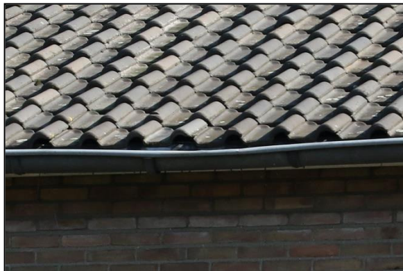
Figuur 13. Dakrand woonhuis met ruimte onder dakpannen.
