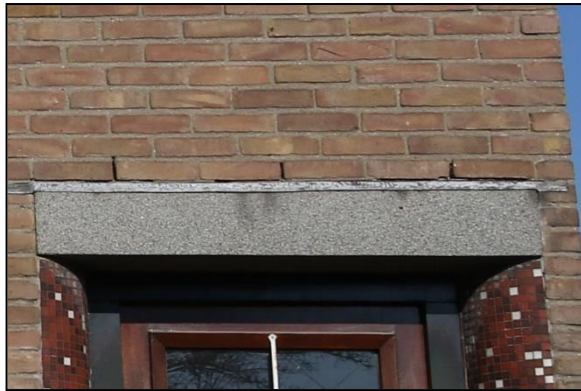
Figuur 16. Stootvoegen boven deurpost.
