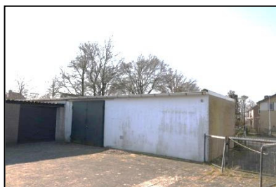
Figuur 9. Schuur en garagebox.
