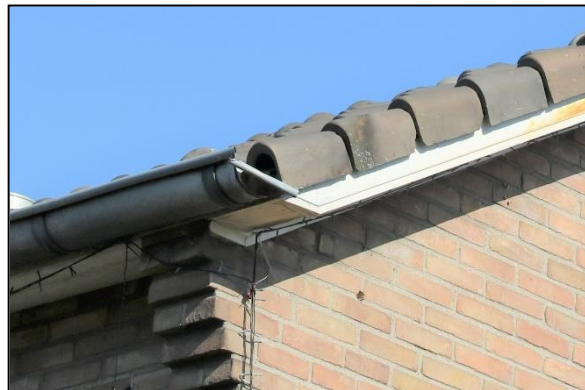
Figuur 14. Hoek woning met geschikte ruimte onder de dakpannen.
