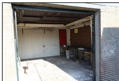
Figuur 10. Binnenzijde garage.
