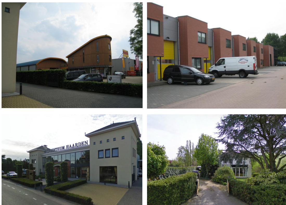
Afbeelding 25: bestaande bebouwing op bedrijventerrein Sluisweg; linksboven de bedrijfshallen van Woerdman en Praxis, rechtsboven bedrijfsunits aan De Steiger, linksonder het pand van Van Benthum Haarden en rechtsonder het bestaande woonhuis in deelgebied het Scharnier
