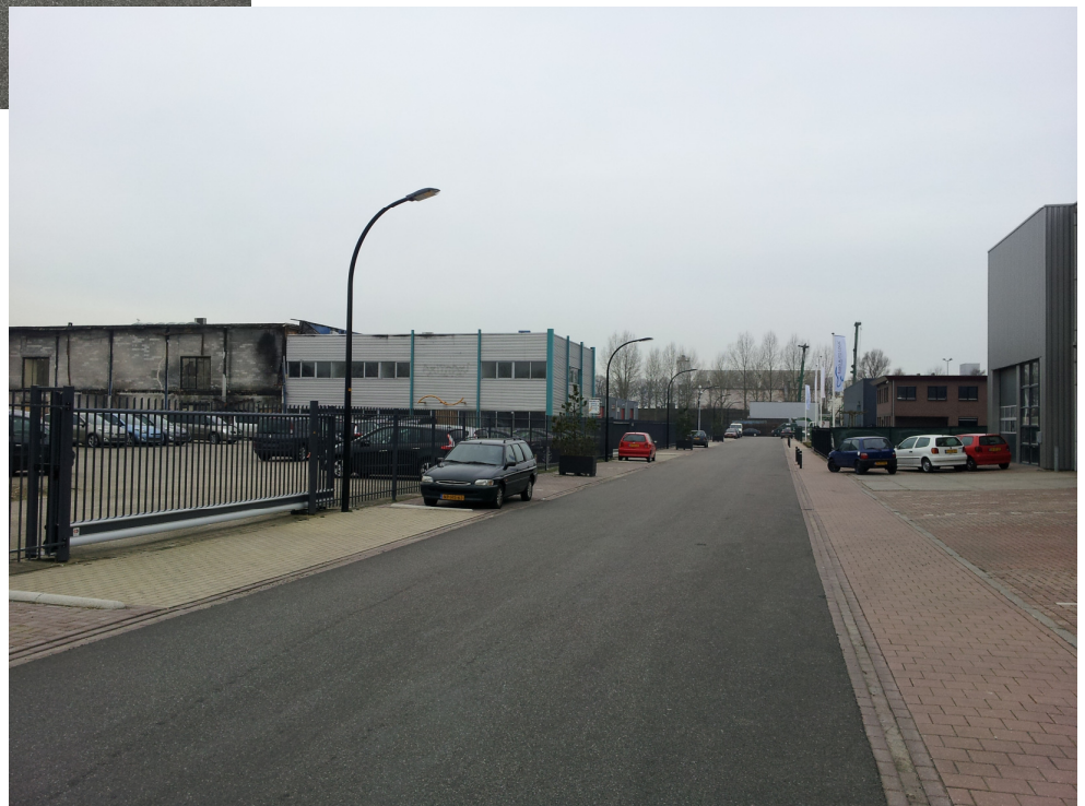
Boven: Bolder met links een gedeelte van het afgebrande pand. Een brede straat met aan de linkerzijde een aantal parkeerplaatsen ( #9 in de lengte van de kavel).
