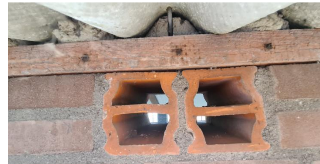
Figuur 5: Detailopname dakrand schuur
