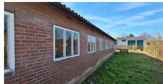
Figuur 6: Westgevel van de schuur
