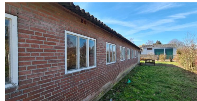
Figuur 6: Westgevel van de schuur
