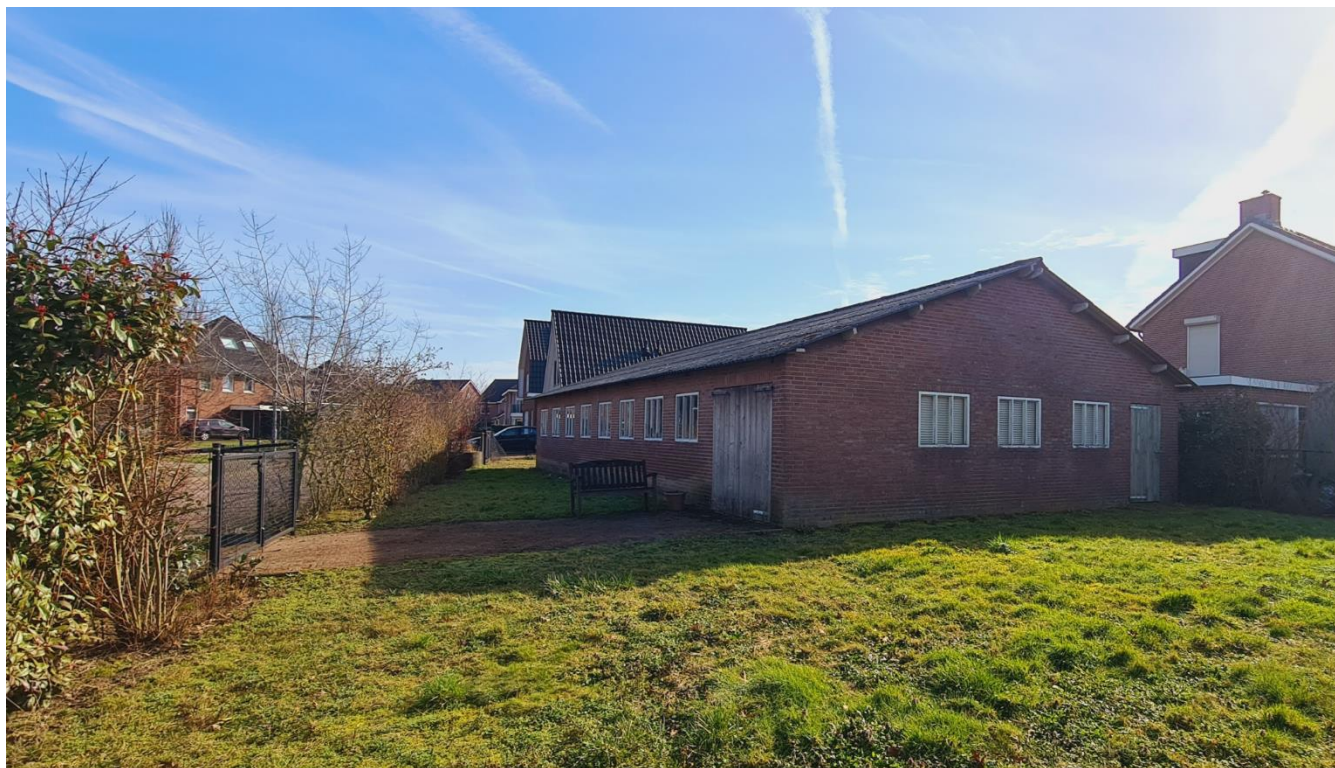
Figuur 4: Schuur en noordelijk gedeelte plangebied, gezien vanaf de Oude Boterdijk
