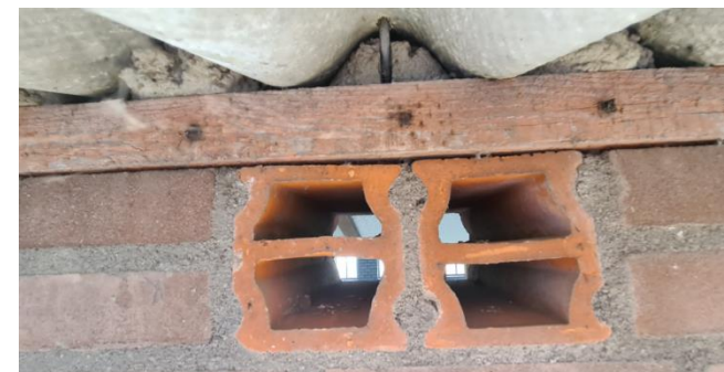
Figuur 5: Detailopname dakrand schuur
