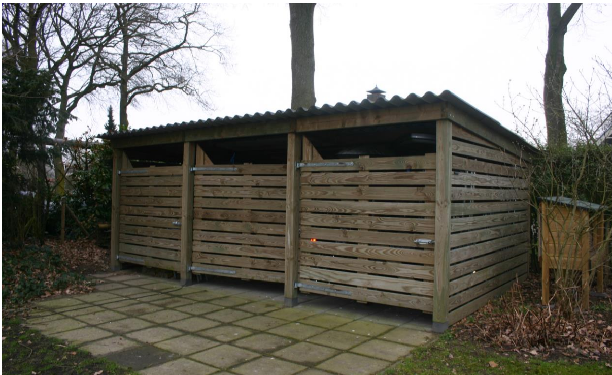
Figuur 4.2. Het opslaghuisje is volledig enkelwandig.
