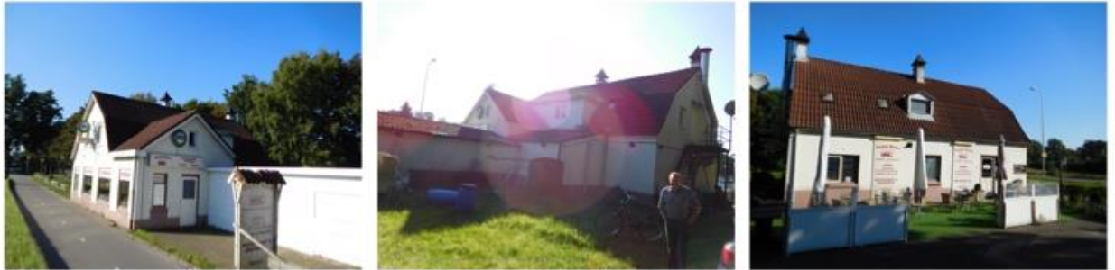
Foto's bestaande situatie
