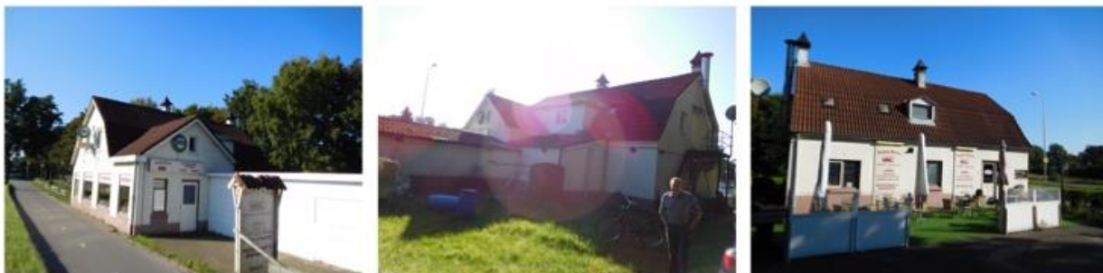
Foto's bestaande situatie
