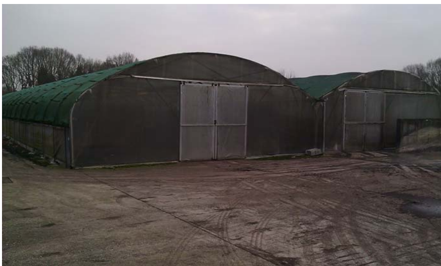
Foto 4 en 5: indruk van de te slopen bebouwing
