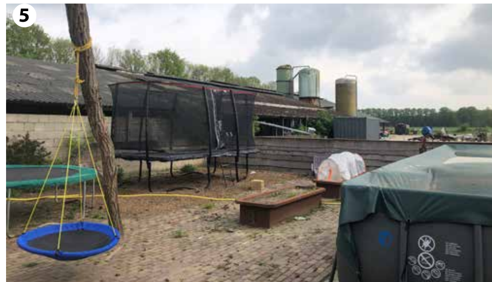
Zicht op de te slopen stallen vanaf de boerderij
