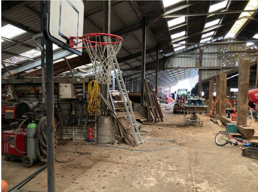
• Afbeelding 19: binnenzijde te slopen rundveestal
