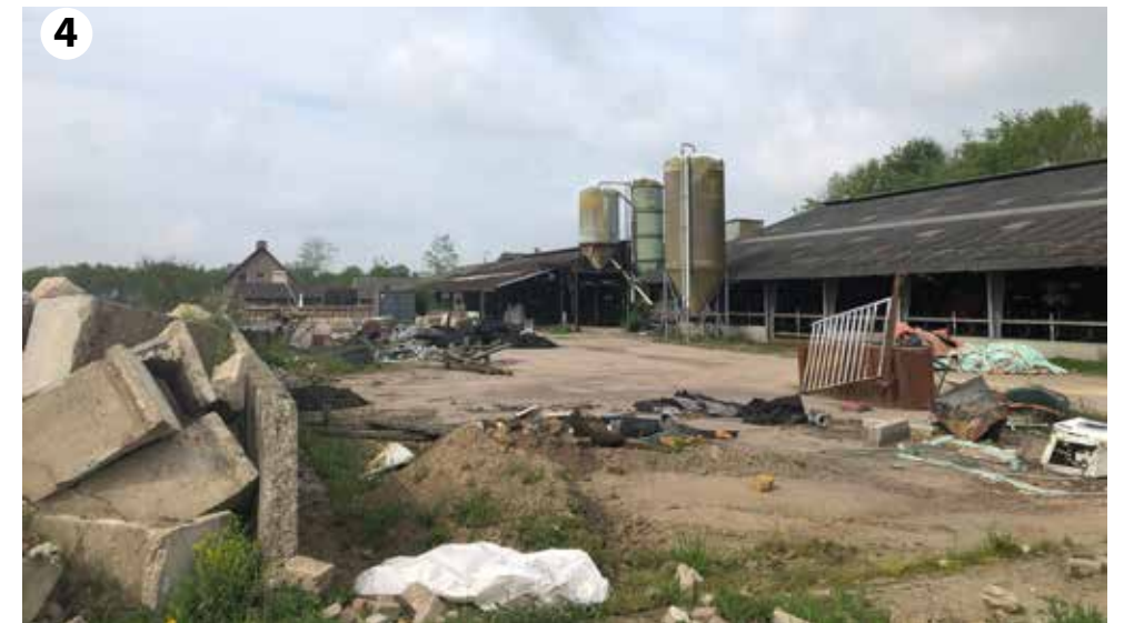
Zicht op de te slopen stallen vanaf de achterzijde van het perceel
