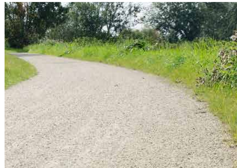
Referentie halfverharding (toegangsweg / paden)
