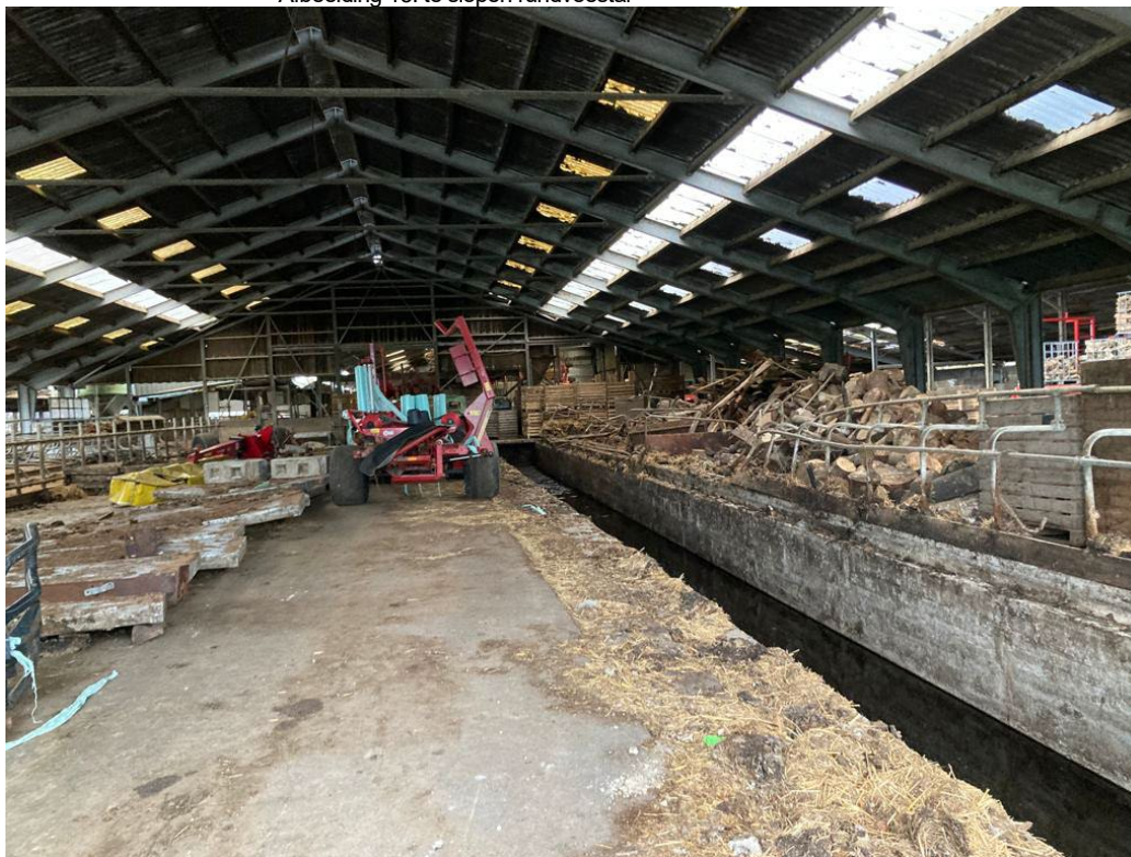
• Afbeelding 15: te slopen rundveestal
