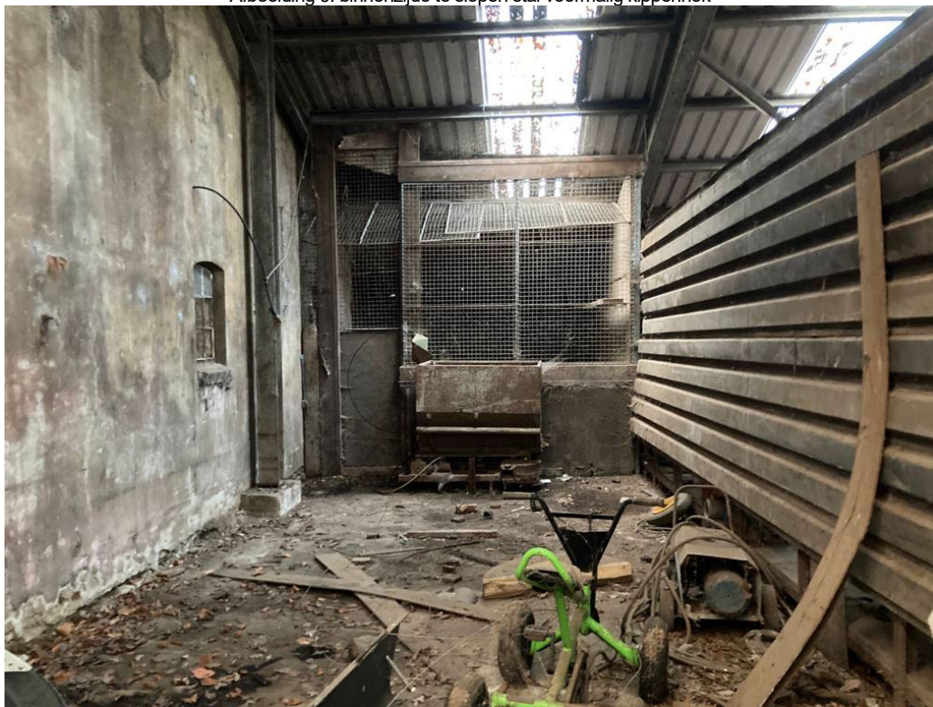
• Afbeelding 9: binnenzijde te slopen stal voormalig kippenhok
