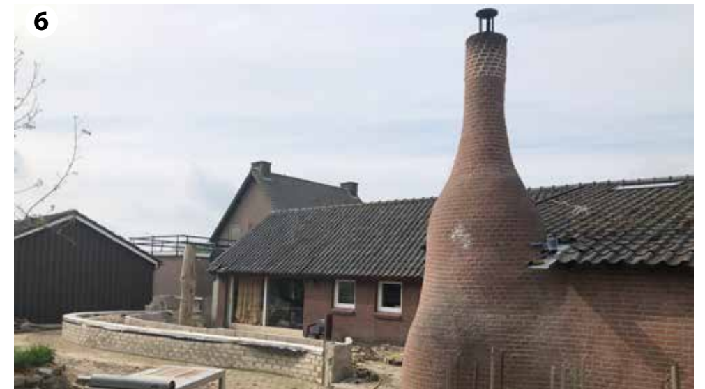
Zicht op het bijgebouw tussen de bedrijfswoningen
