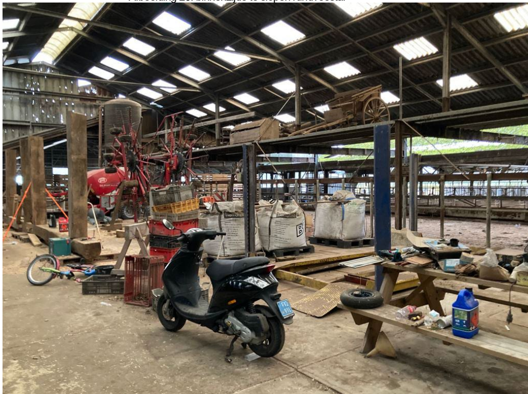
• Afbeelding 20: binnenzijde te slopen rundveestal
